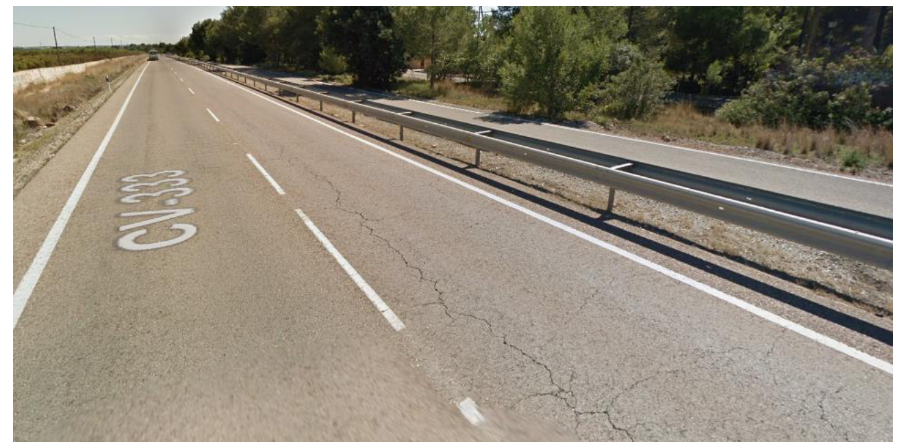
Ilustración 22 – Tramo CV-333 – Separación doble bionda
